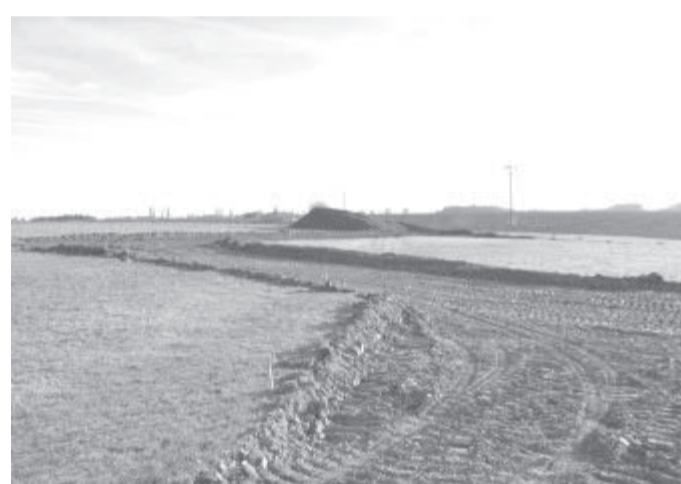
Příprava stavebních parcel ve Vepřikově
