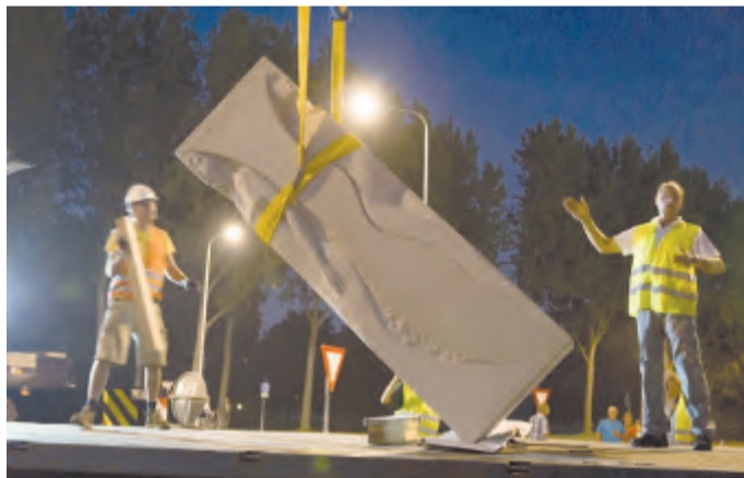
Instalace sousoší proběhla v noci, aby mohla být komunikace s kruhovým objezdem dopravně uzavřena
