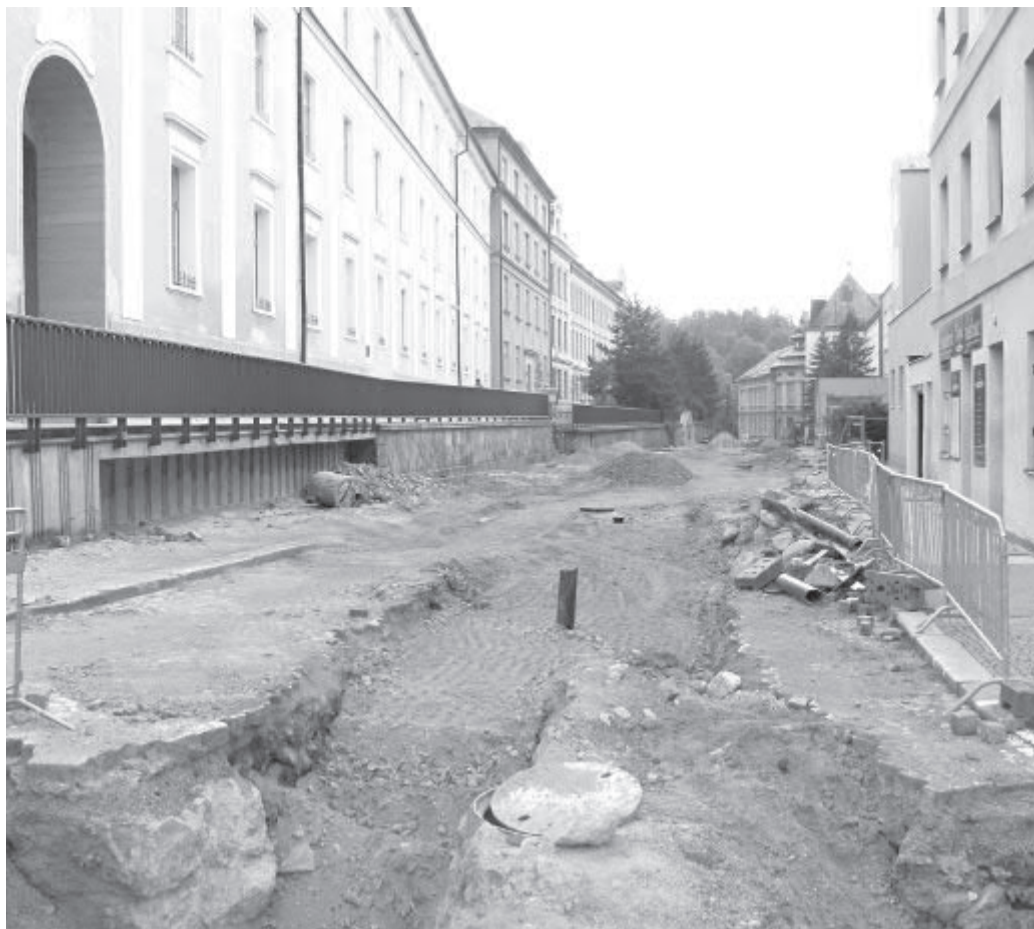
Štáflova ulice je už úplně uzavřena pro veškerý provoz, tedy i pro chodce. Děti ze ZŠ Štáflova využívají provizorní cestičku kolem budovy bývalého okresu, zato studenti gymnázia už nemají ani „svůj“ chodník, musí používat zadní vstup do budovy. V ulici už od června probíhá celková rekonstrukce inženýrských sítí, komunikace a chodníků a potrvá nejméně do poloviny prosince. (foto a text: mal)
