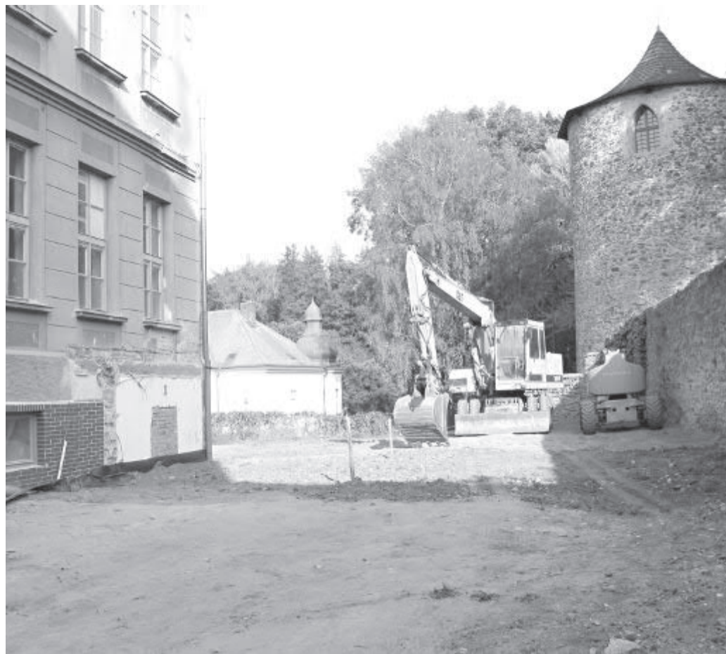
V ulici Boženy Němcové se přes dvůr bývalé Obchodní akademie v Havlíčkově Brodě odkryl pohled na Štáflovu baštu a po bývalé přístavbě už není ani památky. Statiku sousední historické budovy nyní již nevyužívané školy novodobá přístavba ohrožovala, proto město přistoupilo k její demolicí. Na uvolněném místě bude parkoviště a budova bývalé ekonomky bude zřejmě využita pro zdravotní či sociální účely. (foto a text: mal)
