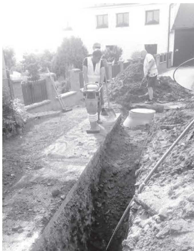
V Miřátkách začala výstavba nové kanalizace.
