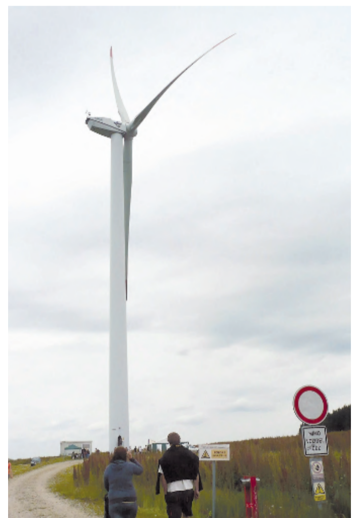
Větrná elektrárna č. 2 focená z dálky.
