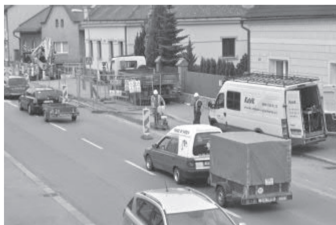
Foto z minulého týdne dokumentuje zahájení další části současné rekonstrukce plynovodu. Práce za plného provozu běžnou dopravu příliš neomezily. Jak rychle začaly tak již skončily. Radikální změna, i pro chodce, však nastane od příštího pondělí (16. 5.) po uzavření mostu přes Žabinec. Je v nevyhovujícím stavu, bude rozebrána následně stavěná nově. Součástí rekonstrukce je vznik odbočovacích pruhů z Humpolecké na Jihlavu, a také na ulici Masarykovu a Kolín. Další bude od hotelu Slunce do centra města. Rekonstrukce mostu odstraní jak jeho nevyhovující stav, tak zvýší únosnost a řídící pruhy zlepší kapacitu křižovatky. Úpravu silnice I/38 zaplatí vlastníci – Ředitelství silnic a dálnic, chodníků a veřejného osvětlení Město Havlíčkův Brod. Kraj Vysočina přidá, včetně DPH, přes 17 miliónů korun. Podle plánu má být havlíčkobrodský most přes Žabinec hotov letos v září. (Připravil JKT)
