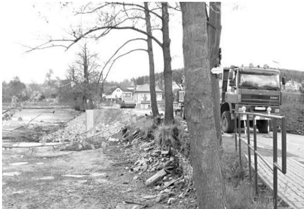
Kvůli opravě výpusti a hráze musel být Zámecký rybník vypuštěn.
